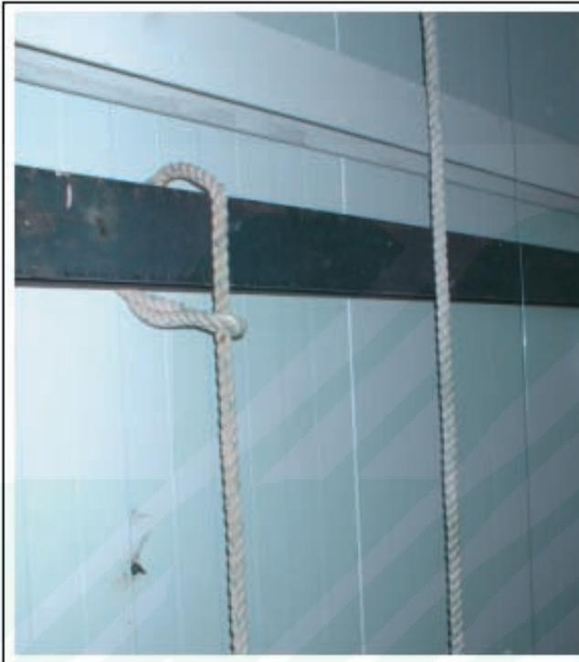
**El sistema constará como mínimo de DOS CUERDAS con sujeción independiente, una como medio de acceso, de descenso y de apoyo (CUERDA DE TRABAJO) y la otra como medio de emergencia (CUERDA DE SEGURIDAD).**
