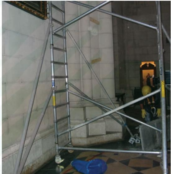
No está permitido mover la torre con cualquier material o persona(s) subidos en la misma. Las torres solo se moverán manualmente y sobre un suelo firme (sólido), nivelado y libre de obstáculos. Durante el desplazamiento no debe superarse la velocidad normal de marcha de un ser humano.
