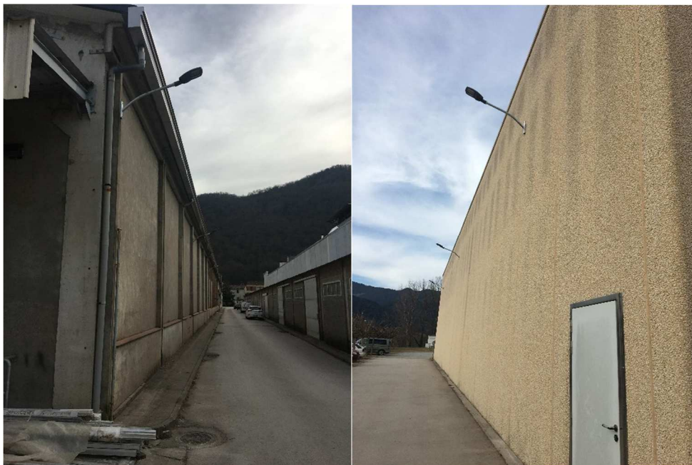
Foto: luces LED exteriores de las naves
