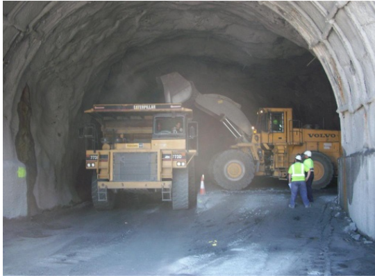
Ampliación para permitir carga en interior del túnel
