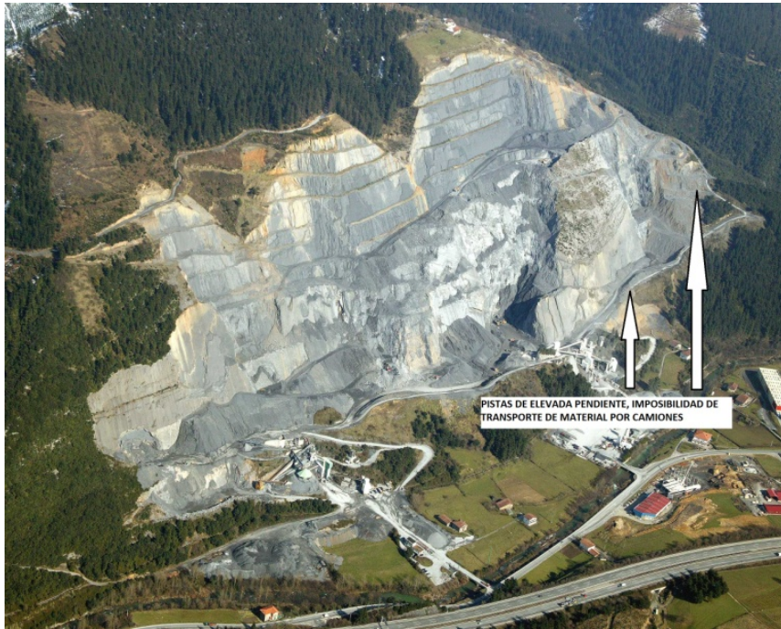
Orografía de cantera. A la derecha pistas sin tráfico tras la realización del pozo túnel
