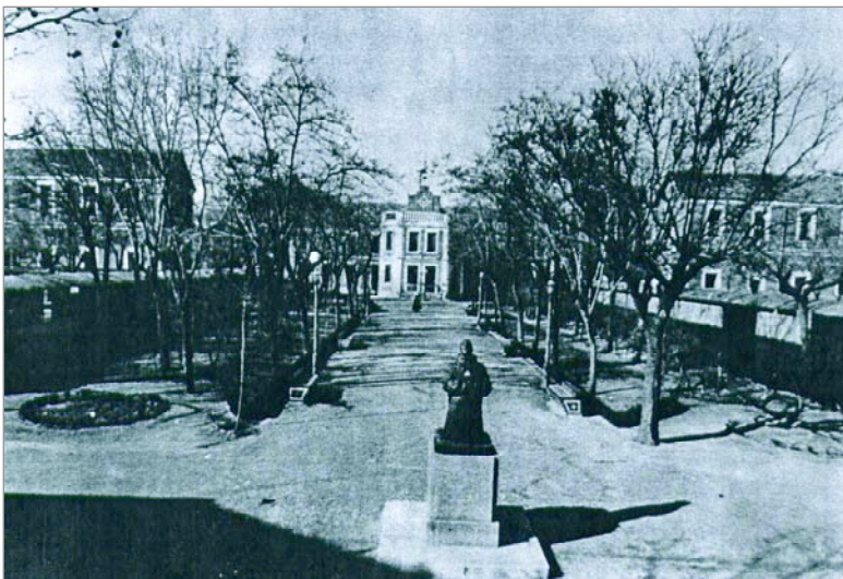
Entrada del Hospital San Juan de Dios.
