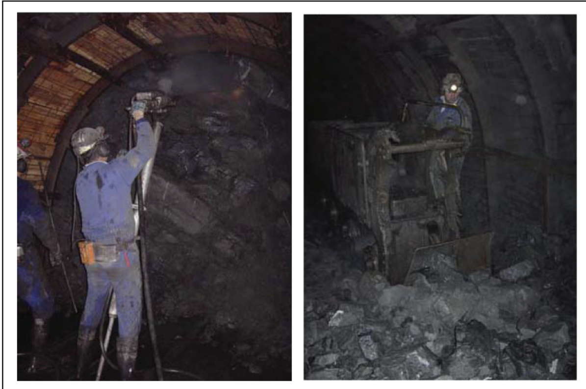
Barrenista (avance “convencional”) trabajando
