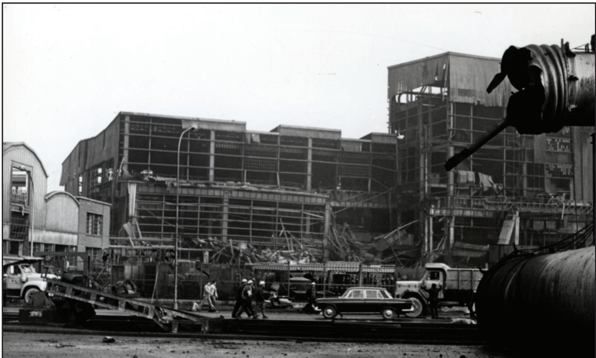
Las piezas proyectadas arrasaron las tuberías generales de distribución de gas, con un diámetro cercano a los 3 m, a la altura del Parque de Bomberos, y que estuvieron soltando gas a la atmósfera durante un tiempo.
