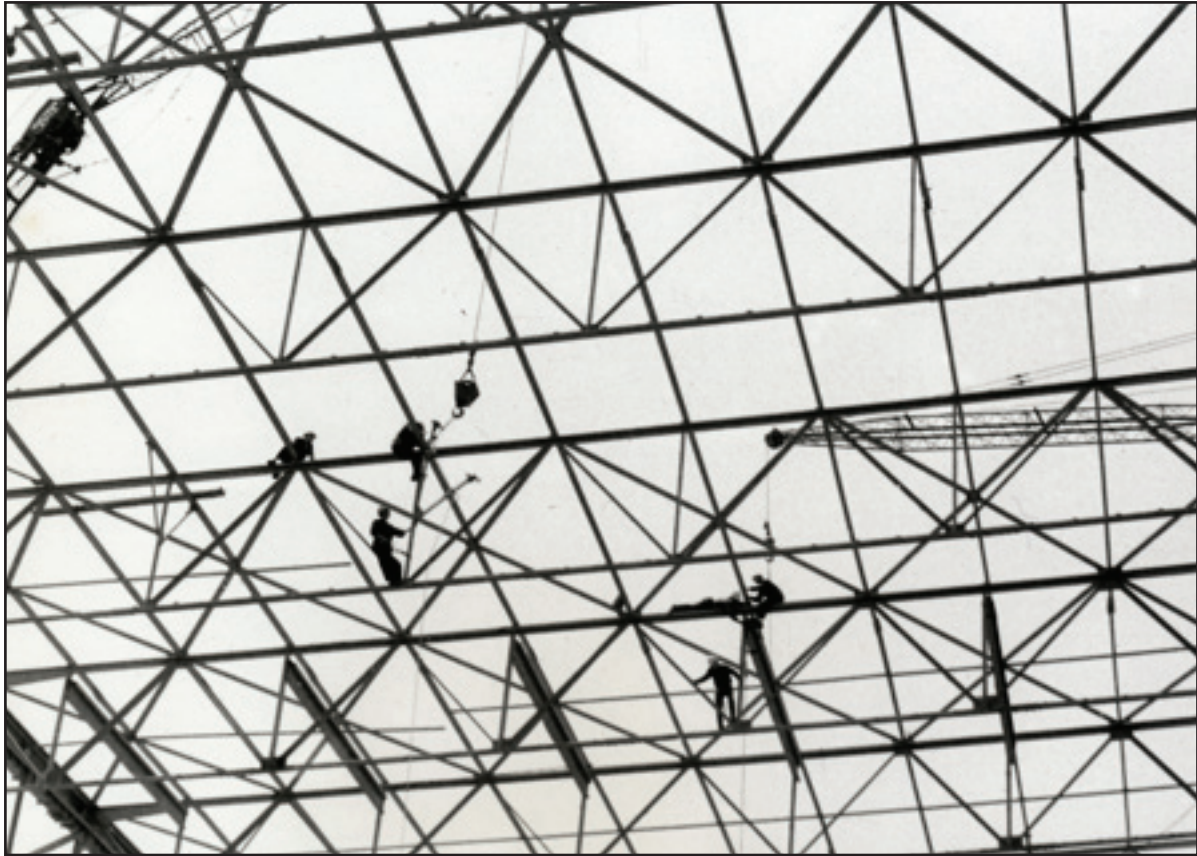
Tejiendo estructuras en el aire.
