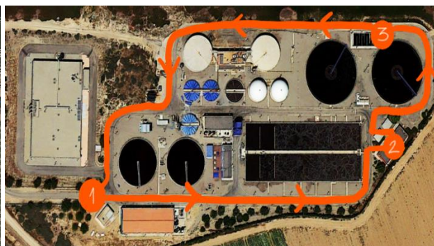
Itinerario descarga de hipoclorito de sodio
