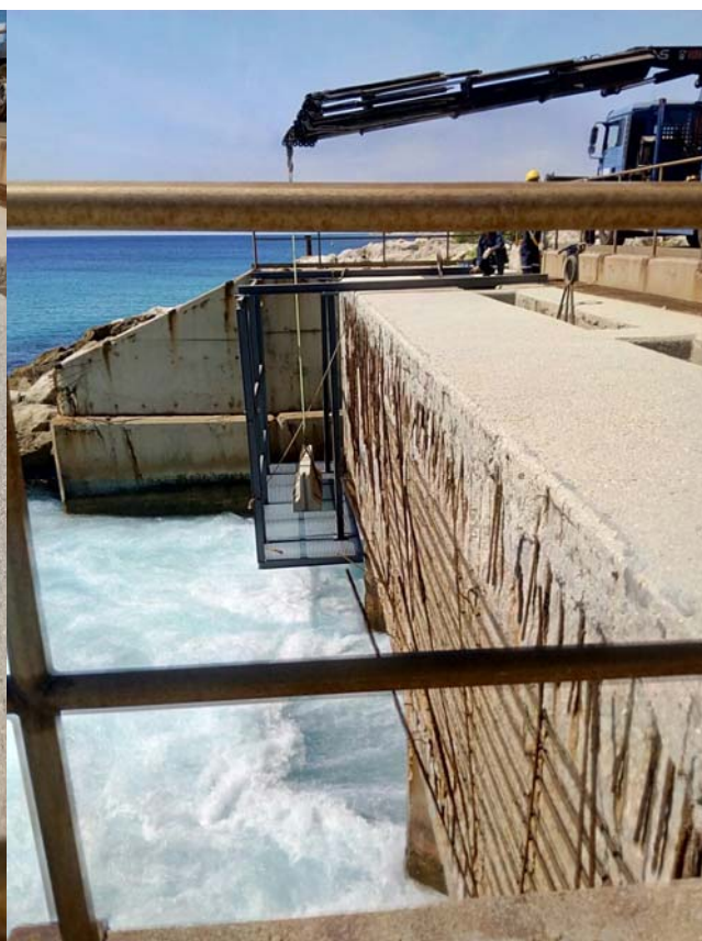
Montaje de plataforma y prueba de carga
