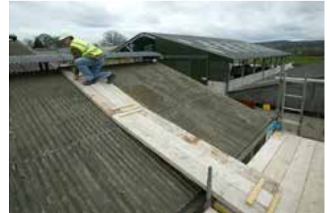
En las cubiertas frágiles, utilice tableros.
