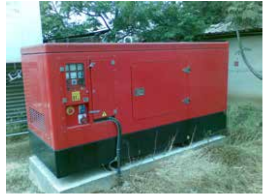
Mantenga los generadores en buenas condiciones.
